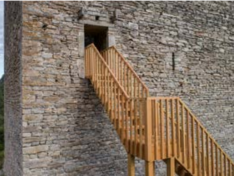
Roman Signer, „Installation am Turm“, 2020, Foto: © Yanis Bürkli, Clus AG
